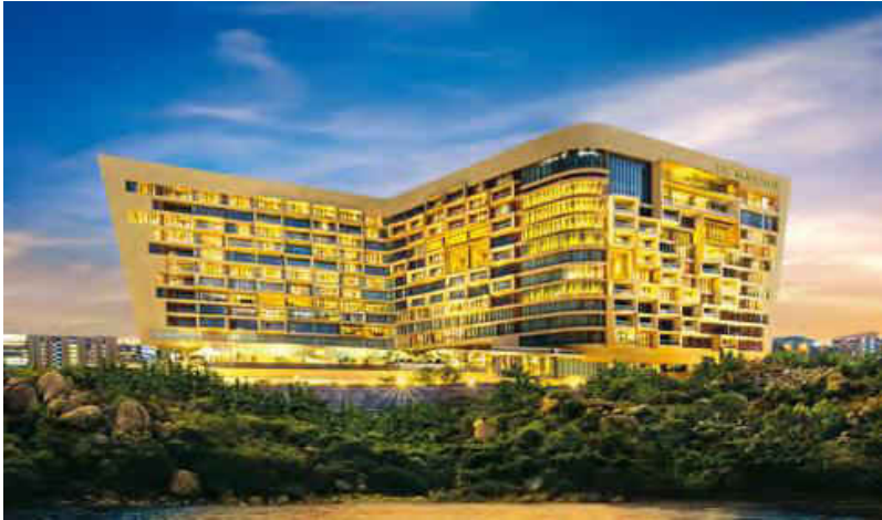
ITC Kohenuur - 271 keys, 6 F&B Outlets
